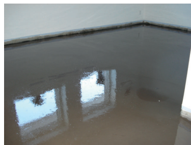
Den færdige Radonsikring efter kun 24 timer
